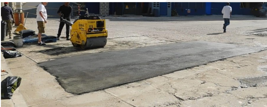
Sellado de grietas y fracturas con sobre carpeta
