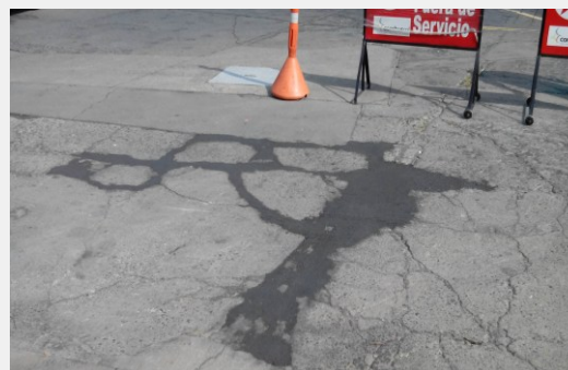
Sellado de grietas y fracturas
