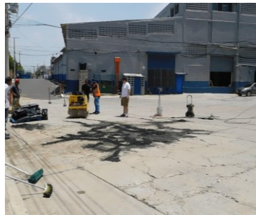
Rellenar con Mezcla Mediana
