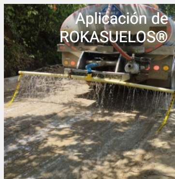
Escarificación y nivelación
